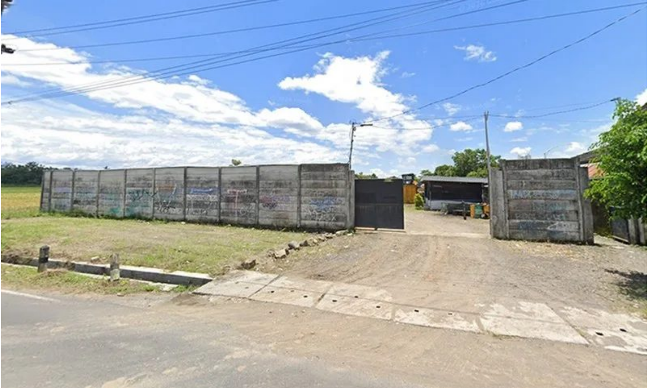
Foto 1 - Tanah Premium 4.700 m2 Jalan Pasar Hewan Gamping Sleman
