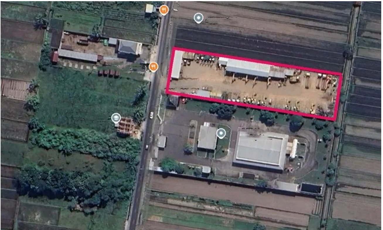
Foto 2 - Tanah Premium 4.700 m2 Jalan Pasar Hewan Gamping Sleman
