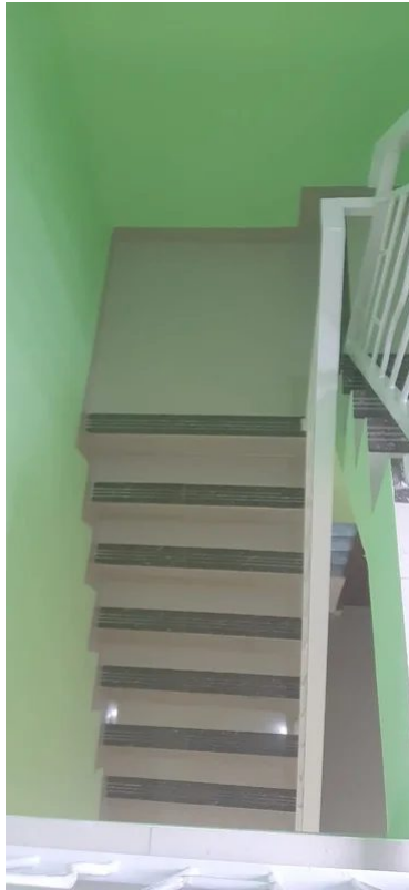
Foto 3 - Rumah Minimalis 2 Lantai Sedayu Dekat Akses Yogyakarta Wates
