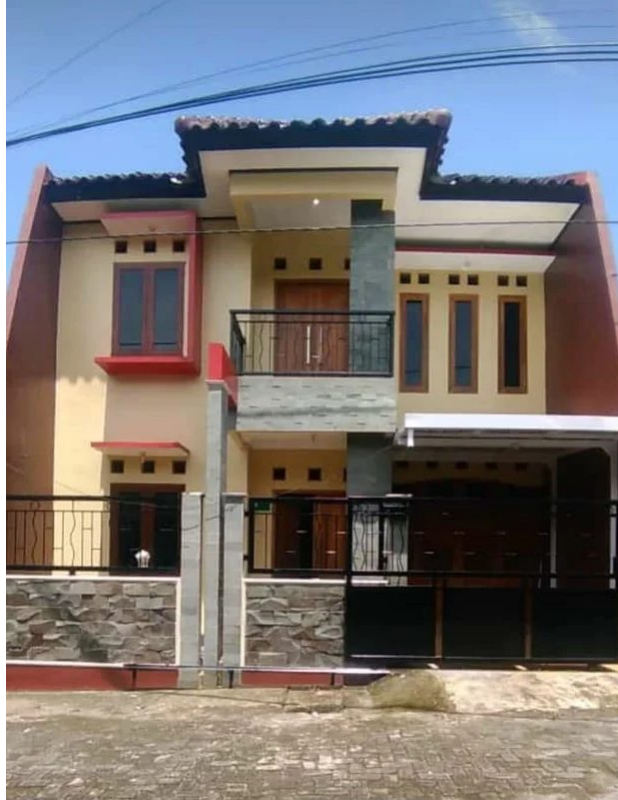
Foto 1 - Rumah Minimalis 2 Lantai Sedayu Dekat Akses Yogyakarta Wates
