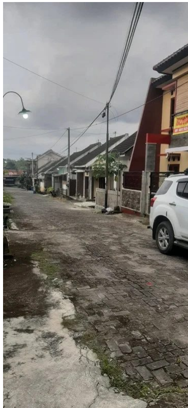
Foto 2 - Rumah Minimalis 2 Lantai Sedayu Dekat Akses Yogyakarta Wates
